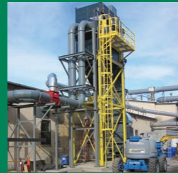
Échangeur de chaleur pour les gaz d'échappement ne pouvant être recirculés
